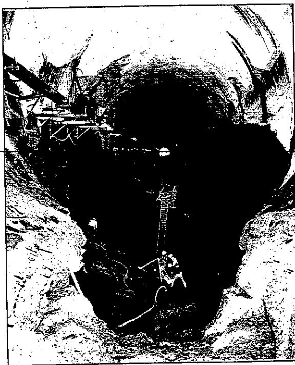
شکل (۲-۱) : تخریب سرریز Glencanyon در اثر وقوع خلاعه‌زایی
